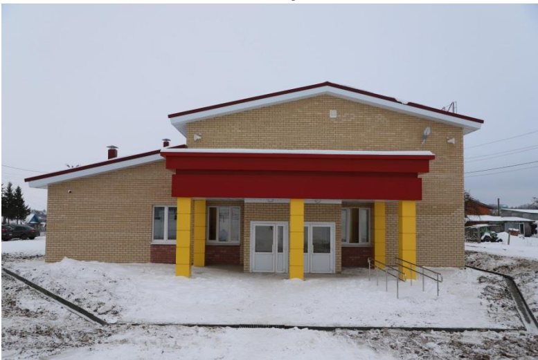
Строительство сельского дома культуры на 150 мест в с. Янгильдино Чебоксарского района
