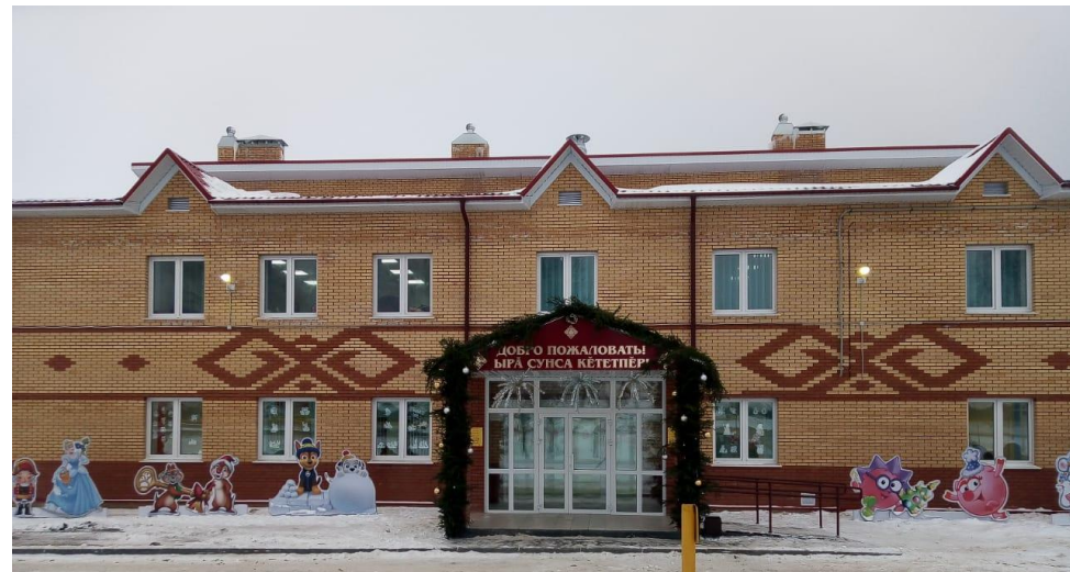
Строительство сельского дома культуры на 100 мест, Канашский район, д. Хучель
