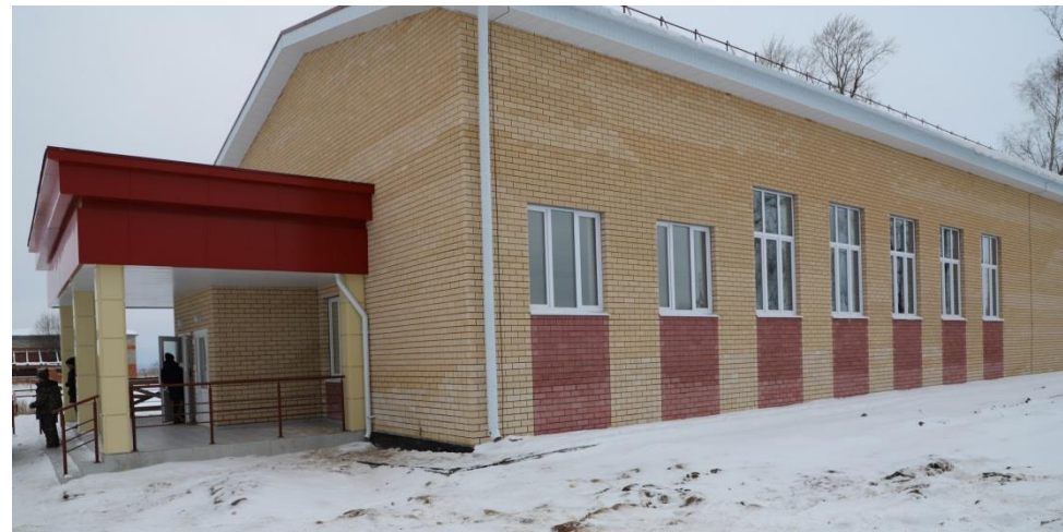
Строительство сельского дома культуры на 150 мест в д. Буртасы Вурнарского района.
