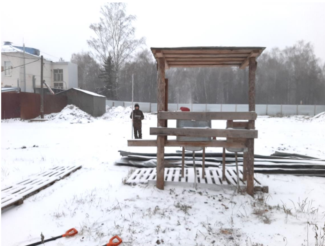
Илл. 16. Вид на обследованный земельный участок с места закладки шурфа 1. Фото с востока.
