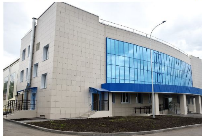
Строительство ФОК Ишлей с 25-метровым плавательным бассейном
